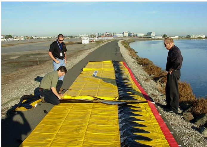
Figure 8. Barrière en toile enduite auto-porteuse - source megasecureurope.com
