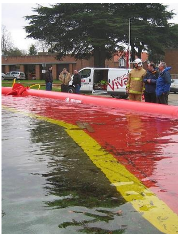
Figure 4. Barrière anti-inondation gonflable à l'air - source esthifrance.com
