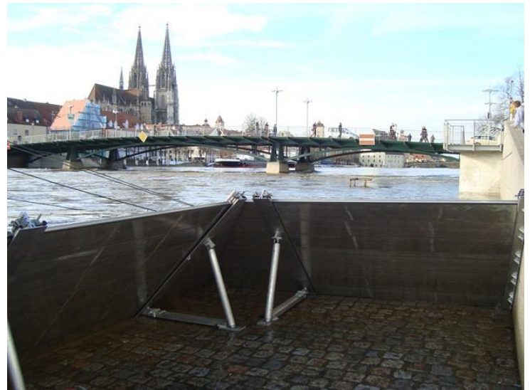
Figure 13. Barrière en aluminium sur support auto-stable mobile - source esthifrance.com
