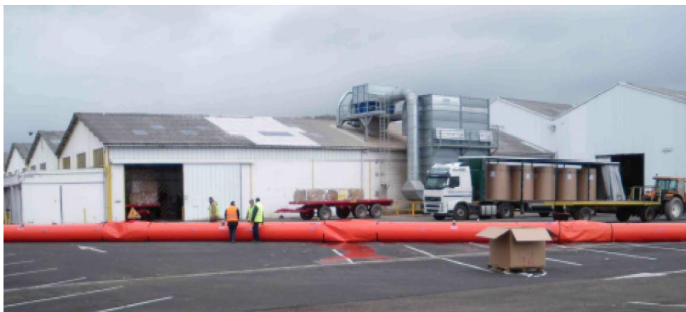
Figure 3. Barrière anti-inondation gonflable à l'eau - source 2leau-protection.com
