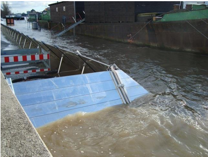
Figure 12. Barrière en aluminium sur support auto-stable mobile - source esthifrance.com
