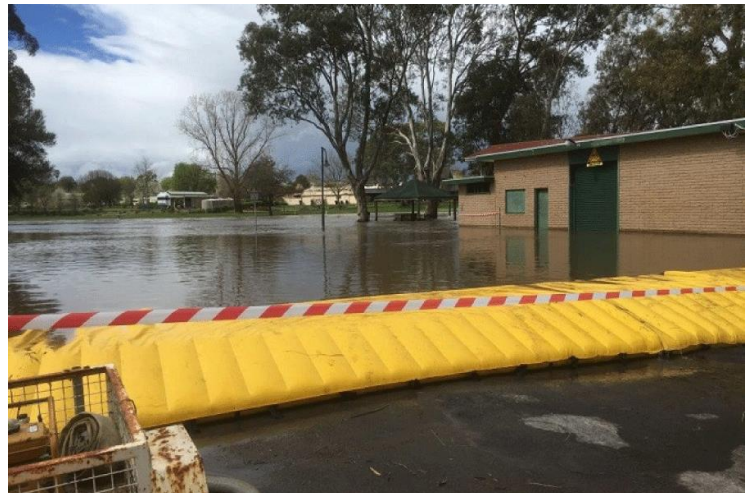
Figure 9. Barrière en toile enduite auto-porteuse - source megasecureurope.com
